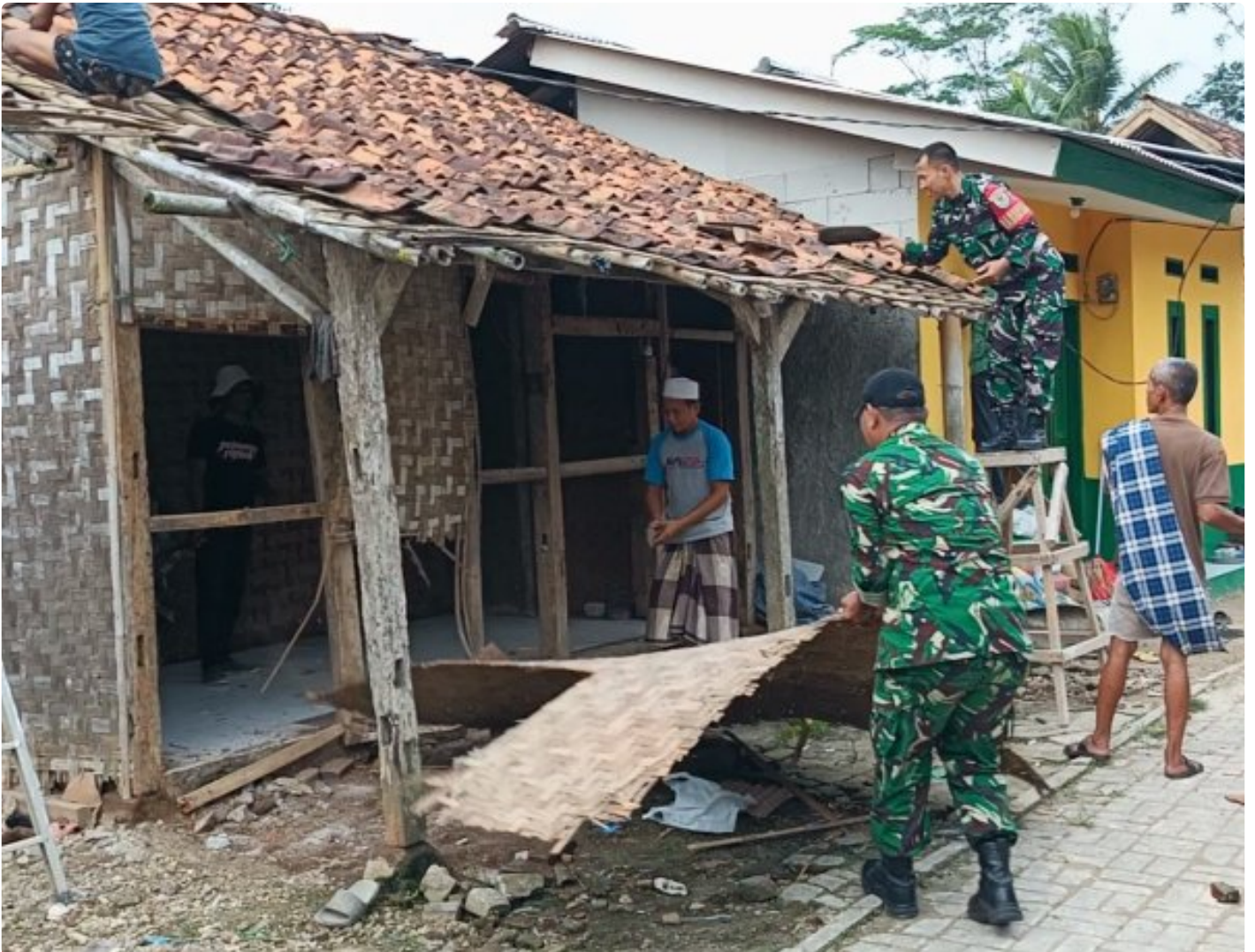
Pembongkaran Rumah Bapak Narmin
