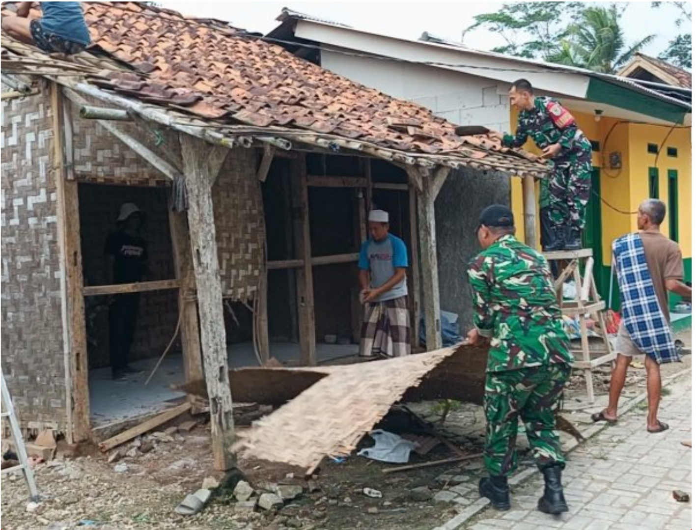
Pembongkaran Rumah Bapak Narmin
